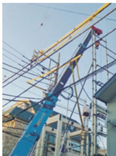
◆ 高圧電気設備は感電防止のため、高圧電線や高圧機器を絶縁養生する必要があります。
